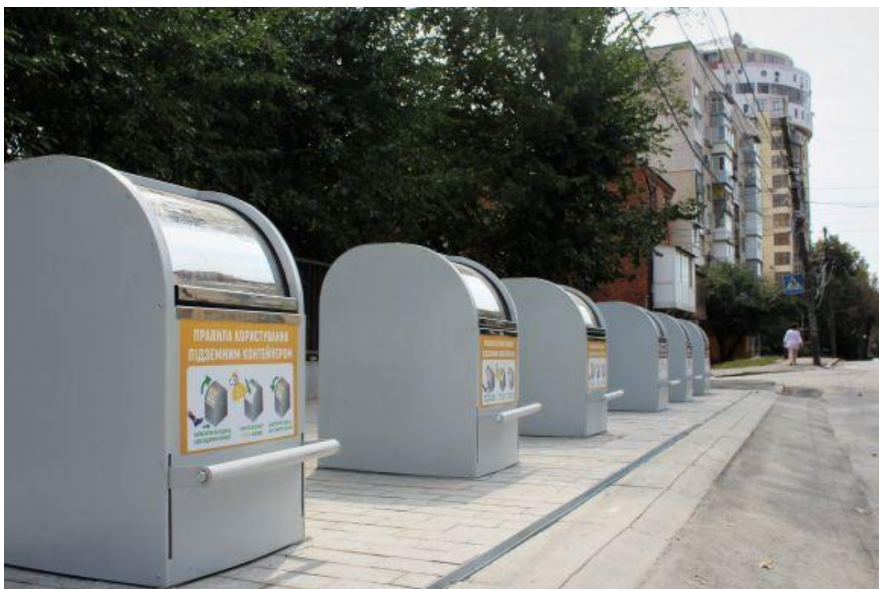
Рис. 1. Підземні баки встановлені в місті Вінниця [1]
